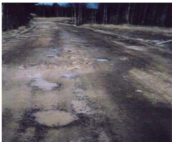
Рис. 1. Состояние дороги через 5 лет после ремонта традиционным способом с традиционными материалами
