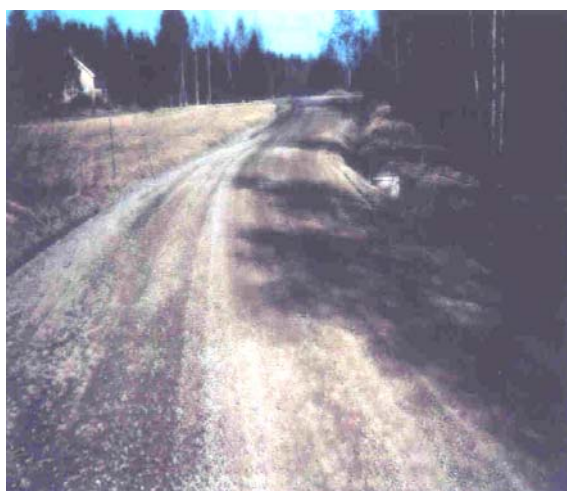
Рис. 2. Состояние дороги через 5 лет после ремонта с использованием летучей золы
