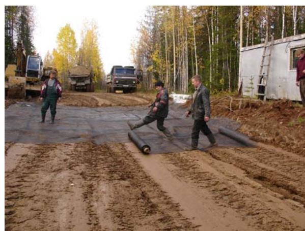
Рис. 3. Укладка геосетки под дорожное покрытие
