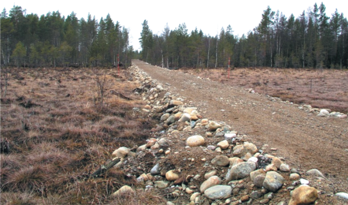
Рис. 8. Пример строительства лесной дороги на торфянике в Швеции. Канавы отсутствуют, достаточно крупные камни положены на геотекстиль и поверхностный слой сделан из мелкозернистого материала
