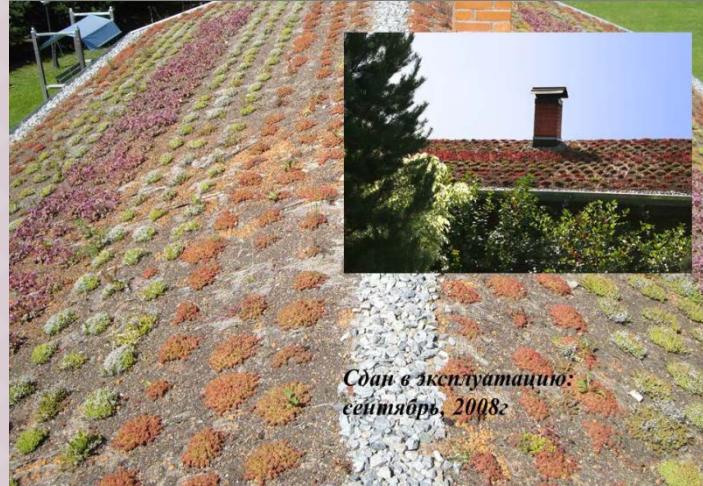
Скатная кровля. Частный дом, Московская область
