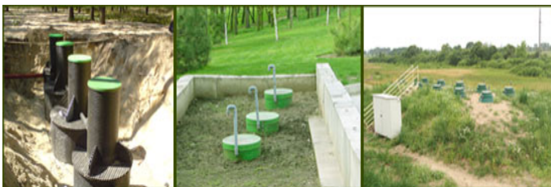
Рис. 7. Установка биологической очистки «ДЖЕРЕЛО»
